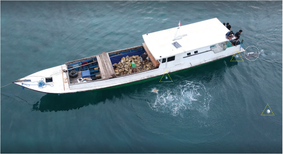
Gambar 19. Proses penurunan instalasi rock pile dari atas kapal dan penataan di bawah air.
